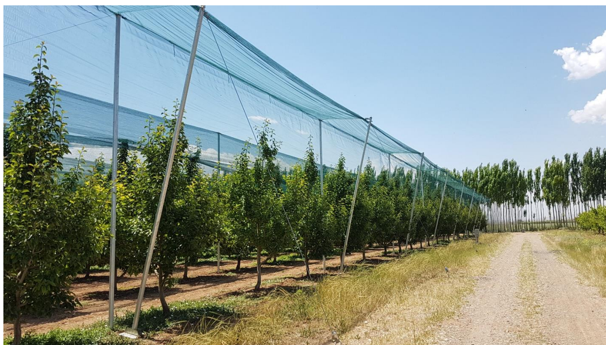
شکل ۳۵: ستون های کناری در گوشه های سازه سایبان ونحو اتصال آن به انکور (عکس از نگارنده)
