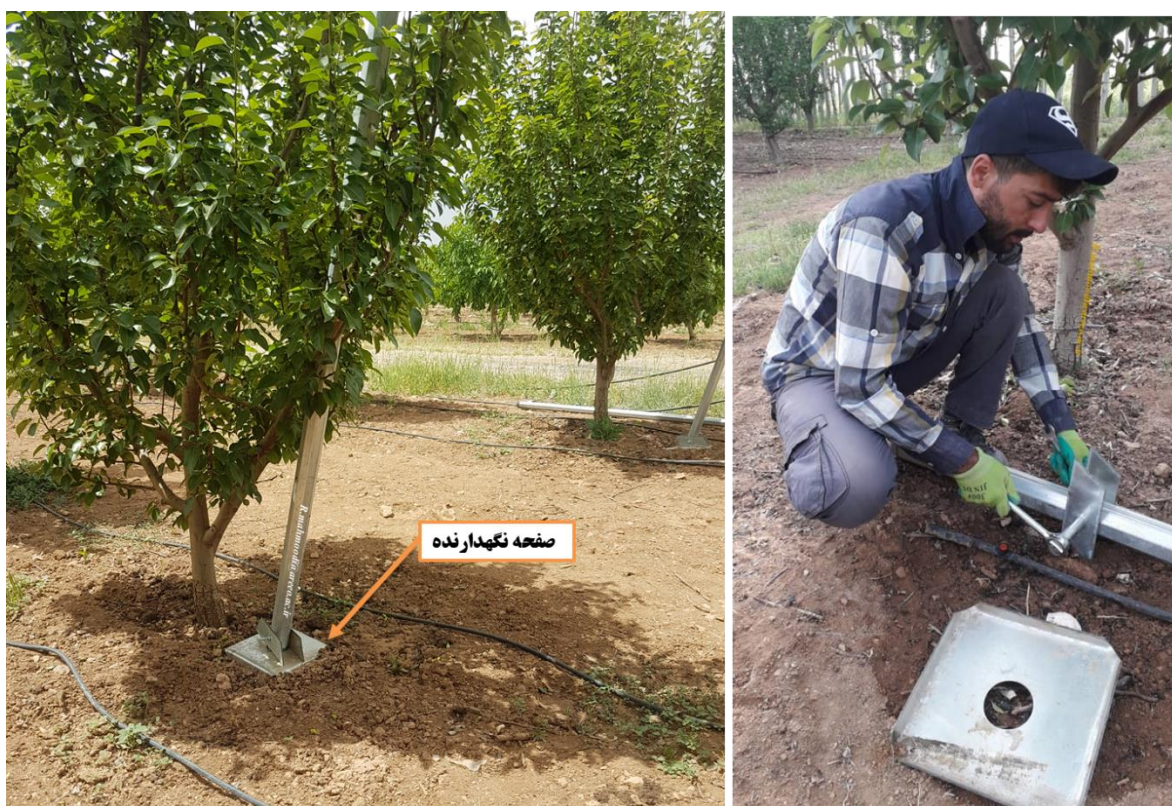
شکل ۱۱: صفحه نگهدارنده ستون‌های کناری فلزی (عکس از نگارنده)
