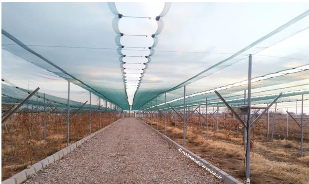
شکل ۱۷: استفاده از نوارهای لاستیکی برای وصل کردن دو لبه توری (عکس از نگارنده)
