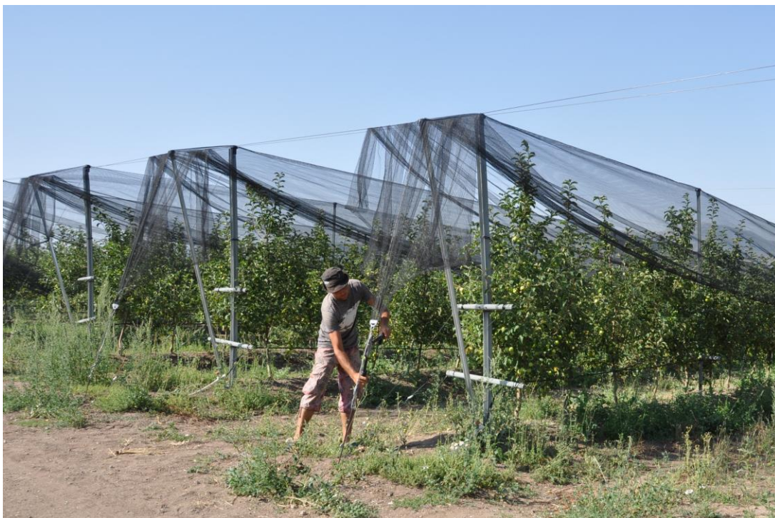
شکل ۴۳: رگلاژ کردن سیم و کابل‌ها در ابتدای فصل (عکس از نگارنده)
