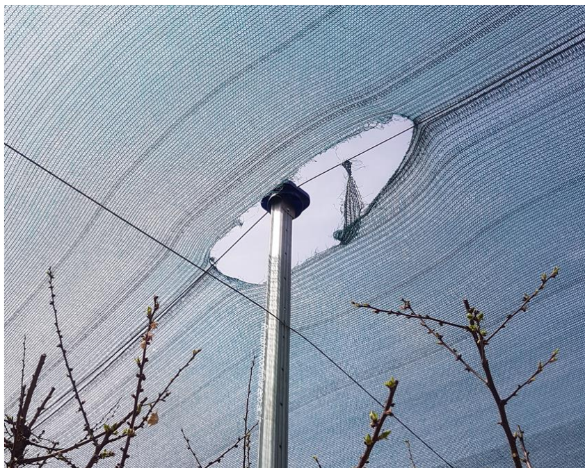
شکل ۴۱: پاره شدن توری در محل سر ستون در اثر کشش بیش از حد توری در روی سر ستون و انتخاب نادرست تیپ سازه سایبان و عرض توری نامناسب (عکس از نگارنده)
