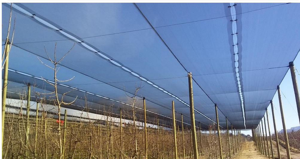
شکل ۶: ستون‌های چوبی در سازه سایبان
