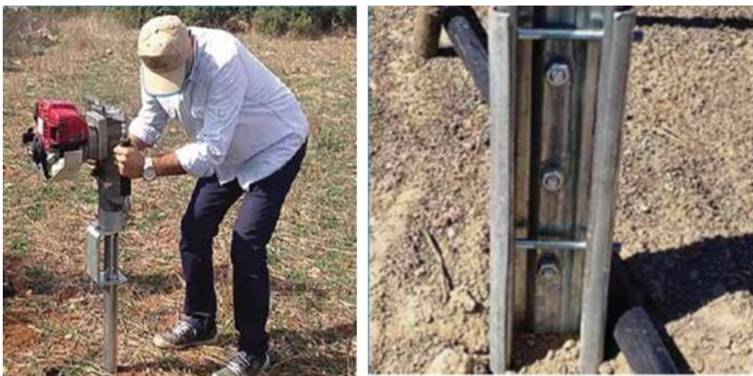
شکل ۳۰: نصب فتینگ پارت و پیچ کردن ستون‌ها روی آن
