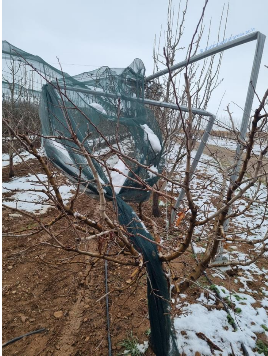
شکل ۴۳: خم شدن ستون‌ها در اثر بارش برف و عدم تحمل سازه به بار برف (عکس از نگارنده)
